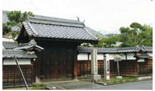
▲落合宿本陣・内扉は加賀藩より火事見舞で贈られたもの。落合宿より十曲峠に入る。
